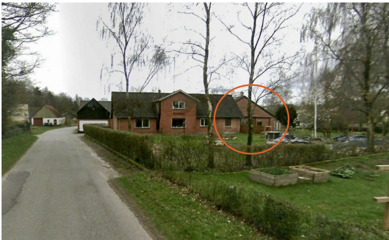
Ejendommen set fra nord. Rød cirkel er den længe, der ønskes nedrevet.
