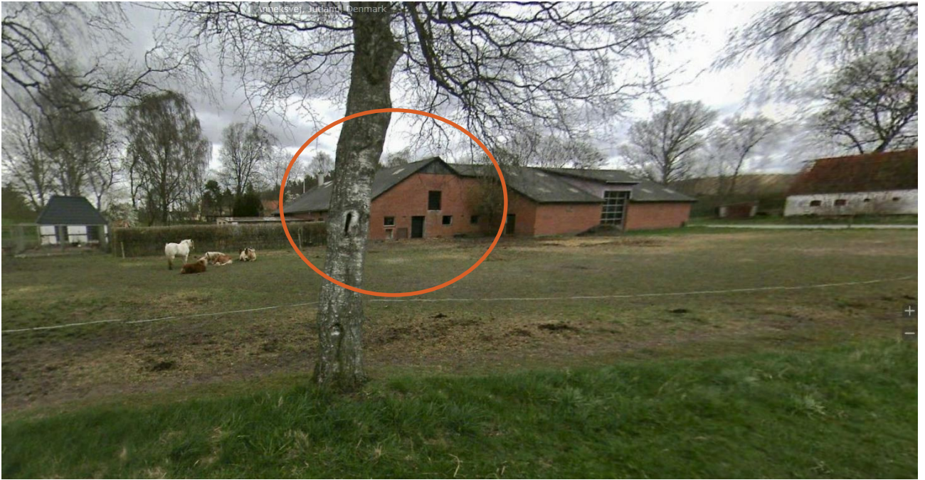
Ejendommen set fra sydvest. Rød cirkel er den længe, der ønskes nedrevet
