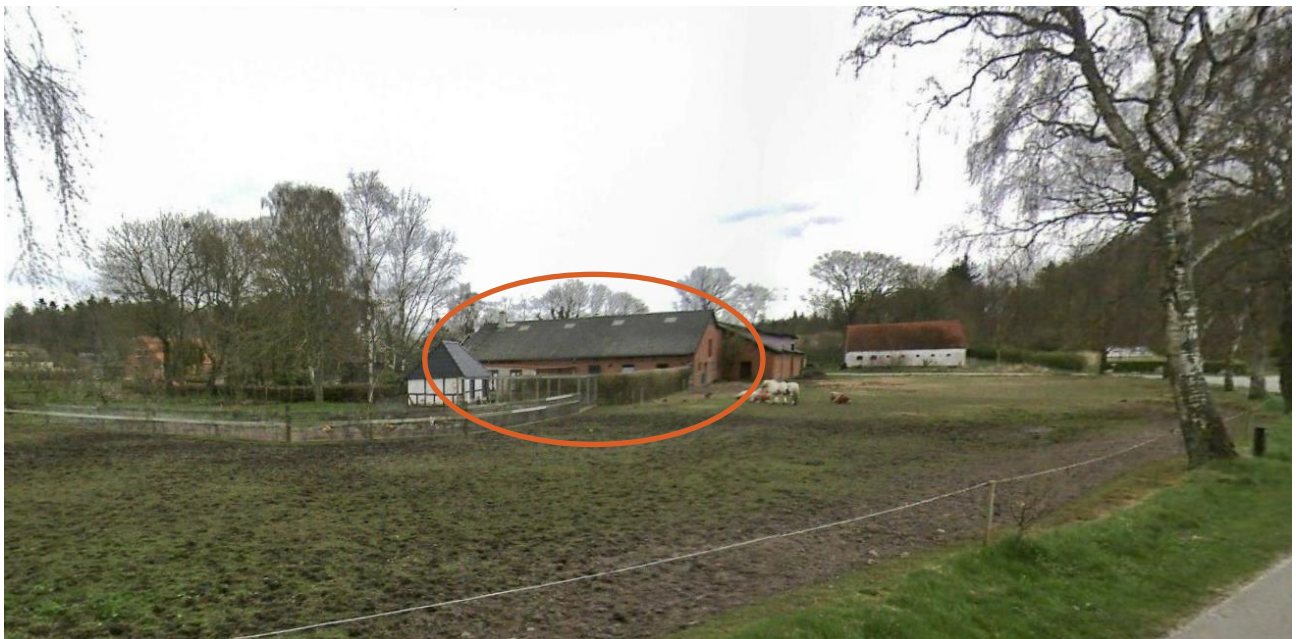
Ejendommen set fra vest. Rød cirkel er den længe, der ønskes nedrevet.
